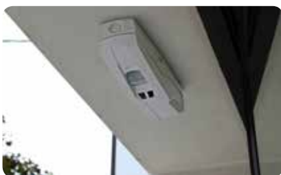
Montaggio orizzontale sull'architrave
