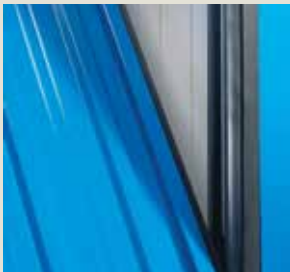
Spazio di sicurezza di 25 mm fra la parte fissa e quella mobile (contro lo schiacciamento delle dita). Le guarnizioni laterali in gomma sono un ulteriore elemento di protezione.
