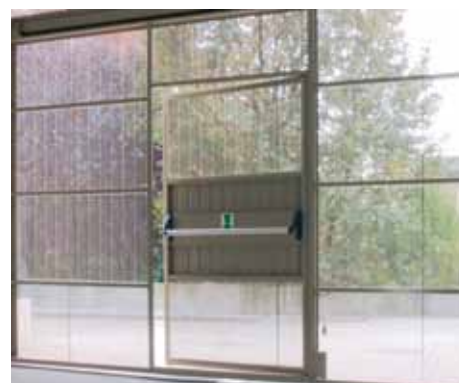
Vista interna porta pedonale da L120 x H 200 in lamiera forata (fori quadri 8x8 mm) con maniglione antipanico BAL 2/C.
