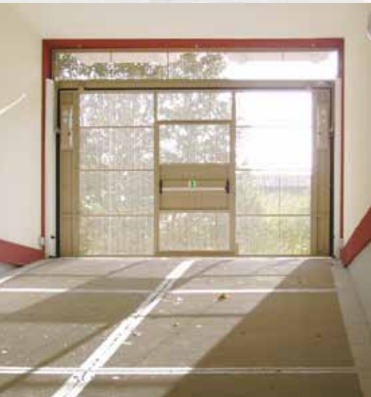
Prospetto esterno della porta basculante con rete da 40x40 mm.
