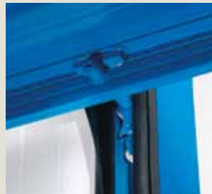
Dispositivo paracadute inserito nelle guide. Agisce in caso di rottura delle funi bloccando la caduta dell'anta mobile.
