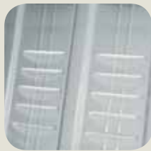
Particolare feritorie d'aerazione poste su 10 file sulla parte superiore ed inferiore dell'anta mobile.
