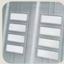
Particolare fori di ventilazione 60x20 mm.
